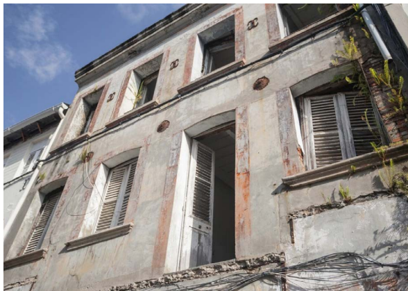
Immeuble du 8, rue Garnier-Pagès à Fort-de-France © Fondation du patrimoine - MyPhotoAgency - Daniel Brieu
