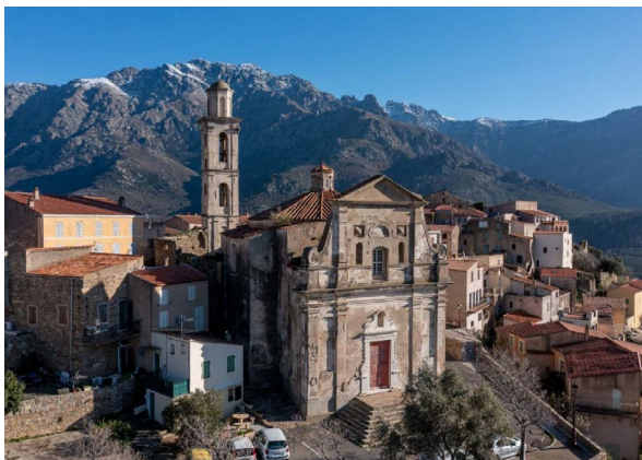
Église Saint-Augustin de Montemaggiore à Montegrosso © Fondation du patrimoine - MyPhotoAgency - Julien Angella
