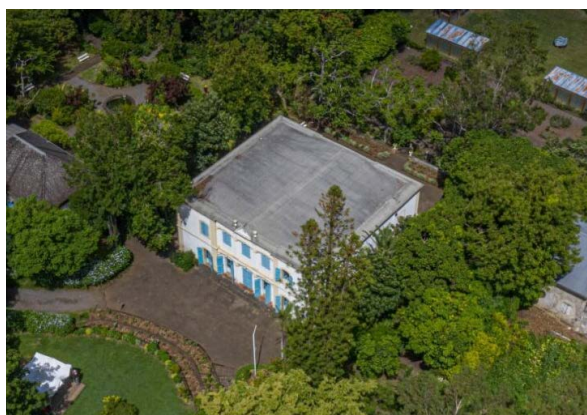
Bâtiments historiques du musée de Villèle à Saint-Paul © Fondation du patrimoine - MyPhotoAgency - Julian Apavou
