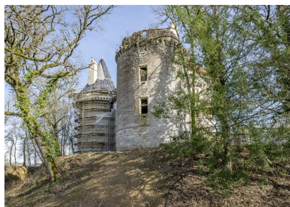
Tour Sud-Ouest du château de l'Herm à Rouffignac-Saint-Cernin-de-Reilhac © Fondation du patrimoine - MyPhotoAgency - Norman Lewis
